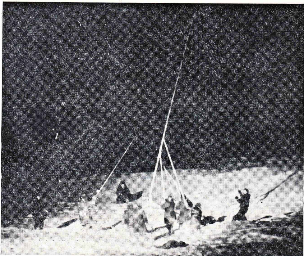
В темноте полярной ночи, прорезаемой лучом прожектора, идет напряженная работа: на дрейфующей льдине оборудуется автоматическая метеостанция. Люди улетят, а радиовежа начнет свой дрейф в океане.
